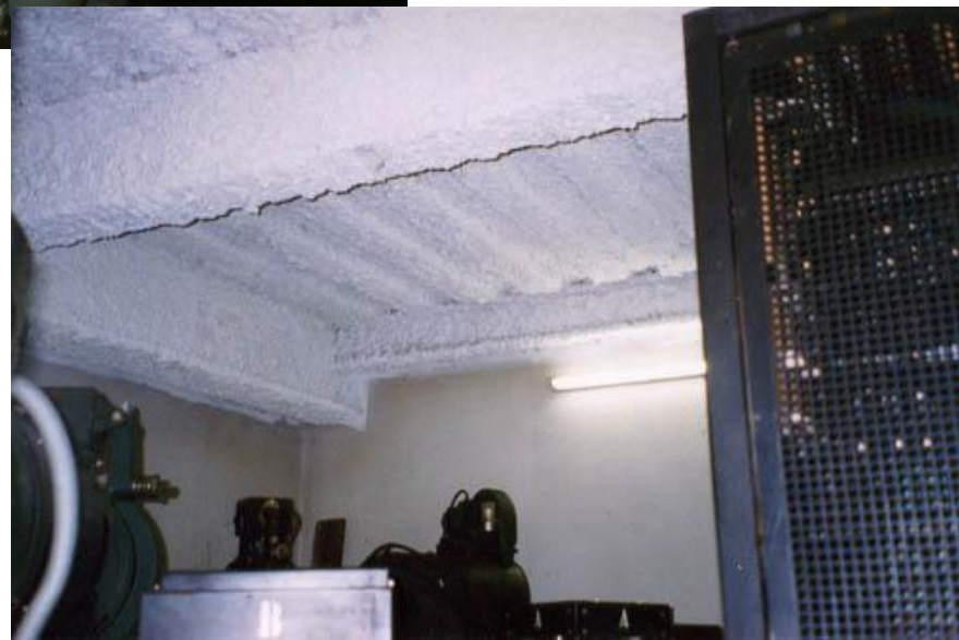
Intonaco a spruzzo
